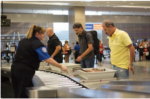
Şəkil 1. Las-Veqasda Makkarrananın Beynəlxalq aeroportunda paralel sürətli nəqliçici lent
