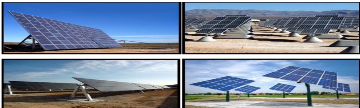
Şəkil 2. Tək oxlu və iki oxlu Günəş izləyiciləri
